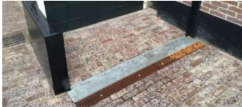
Figuur 6: Zelfopdrijvend schot (SCFD - Self Closing Flood Barrier)
